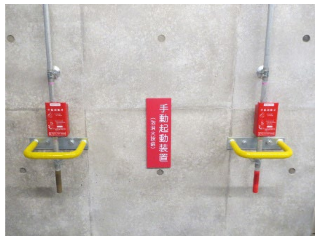
手動起動装置に保護ガードを設置
