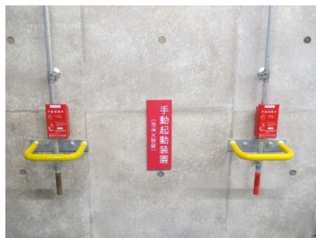
手動起動装置に保護ガードを設置
